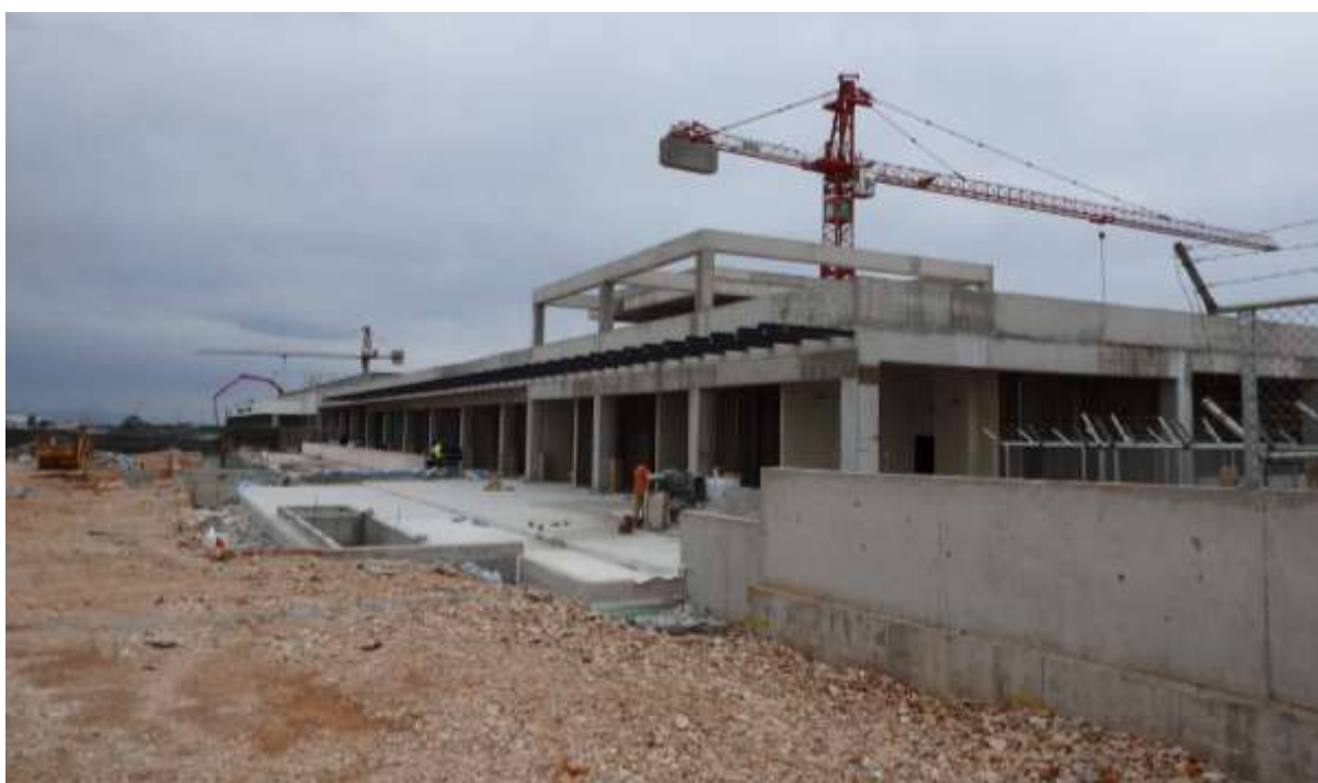
Ανατολική επέκταση κτήριο Αεροσταθμού Αεροδρομίου Χανίων σε φάση κατασκευής
