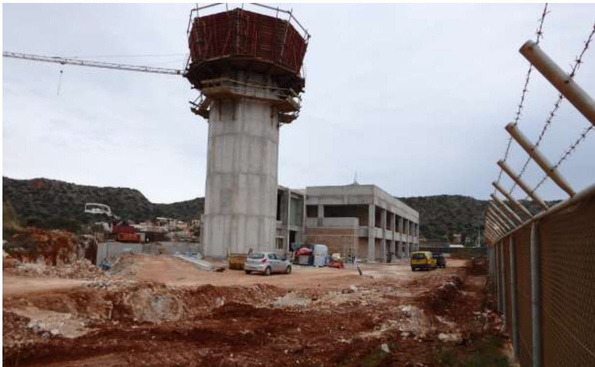
Άποψη του Πύργου Ελέγχου του Αεροδρομίου Χανιών σε φάση κατασκευής
